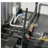
Система подкачки топлива управляемая контроллером Siemens logo посредством программы разработанной нашим предприятием. Подкачка топлива осуществляется встроенный бак электростанции, при снижении уровня больше допустимого. Работа системы подкачки топлива происходит полностью в автоматическом режиме. Объем внешней емкости подбирается потребителем в зависимости от необходимого времени автономной работы.
